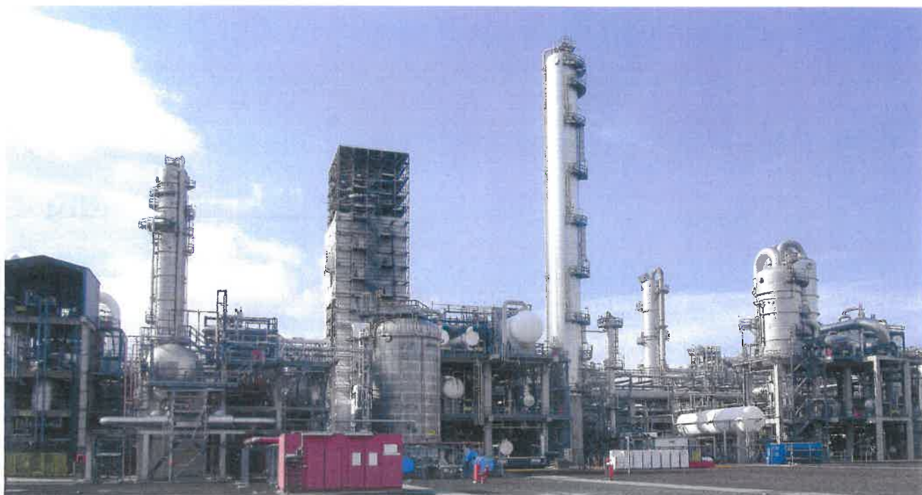
De totale upgrading van torens, vaten en leidingbruggen zal duren tot ongeveer 2025. Hier in het midden een van de torens in de steigers.
